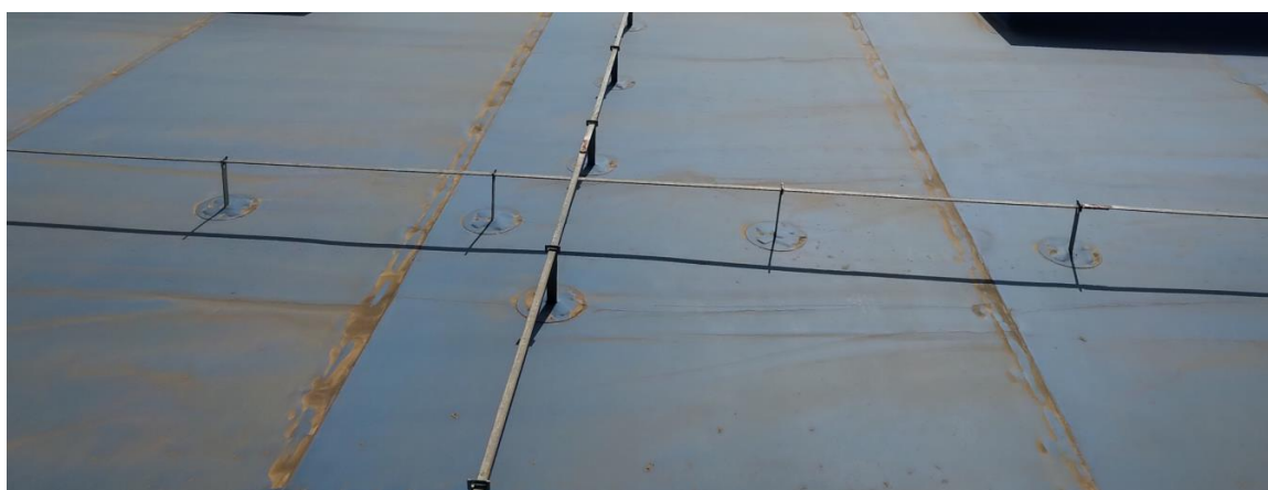
屋顶接地网敷设示意图
